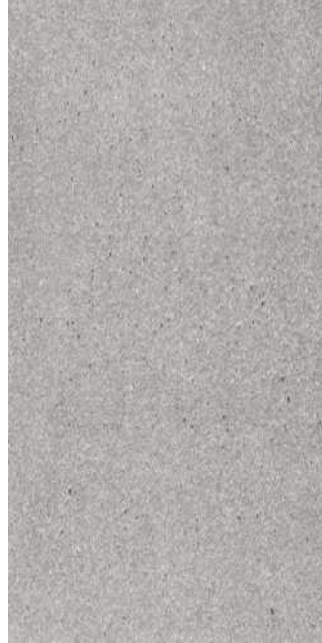
Concreto Aparente En Escaleras
