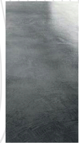
Concreto Pulido Sótano y Cubiertas De Rooftop.
